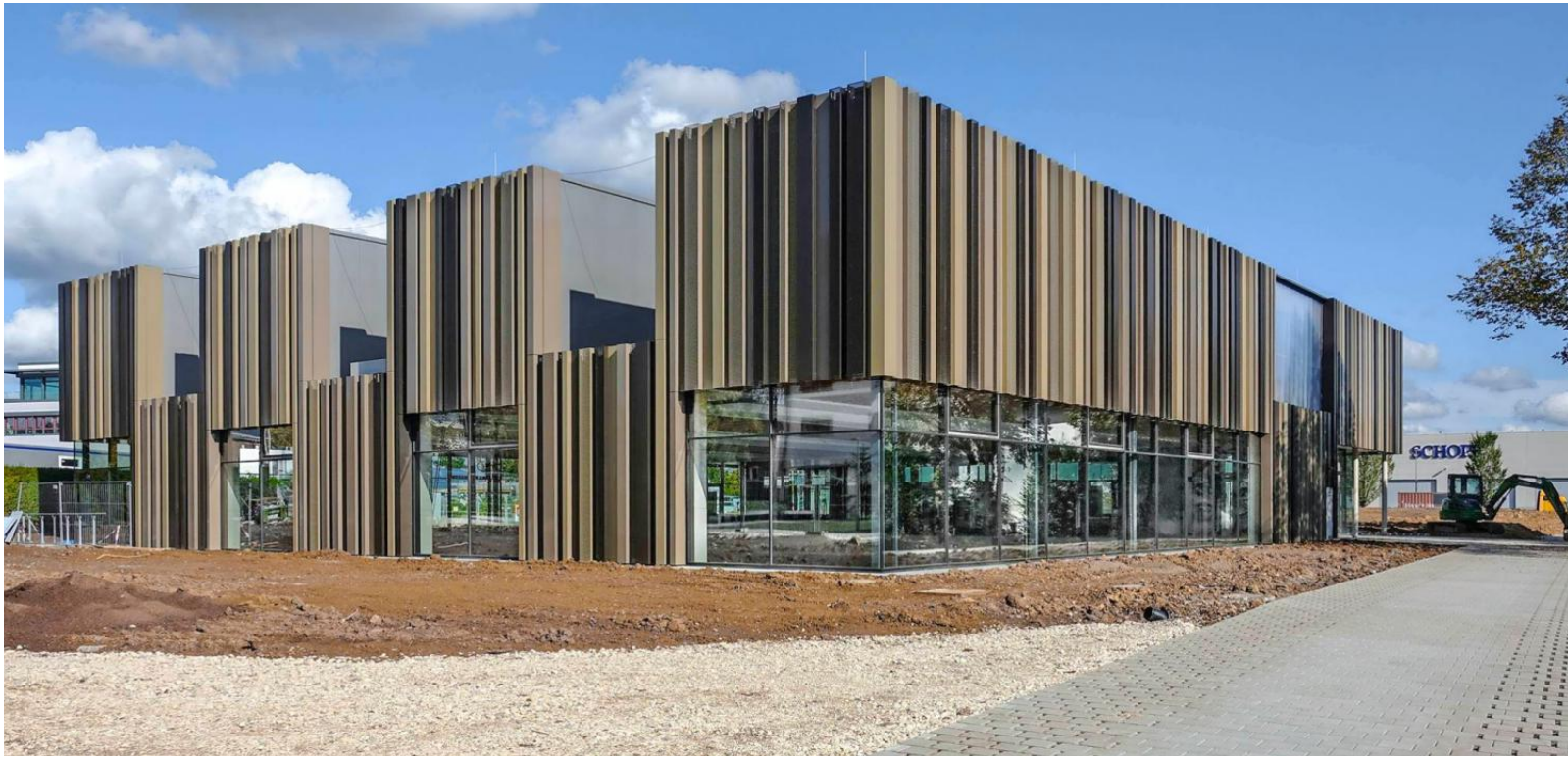
Die Architektur des Neubaus ist rhythmisiert. Im Untergeschoss liegt die Sporthalle, die Riegel im ersten Obergeschoss sind auch für die Belichtung vorgesehen. FOTOS: KAUFFMANN THEILIG & PARTNER
